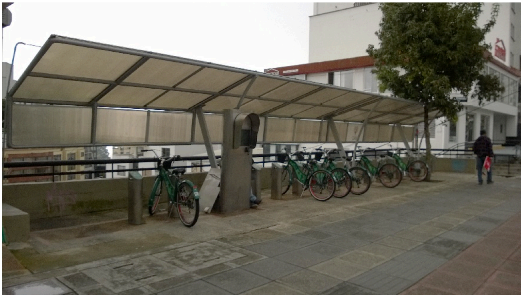
Figura 10. Estación 8 (E8) - Calle 52
