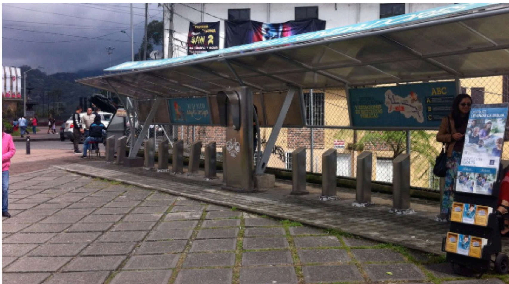
Figura 5. Estación 3 (E3) - Cable Aéreo Fundadores
